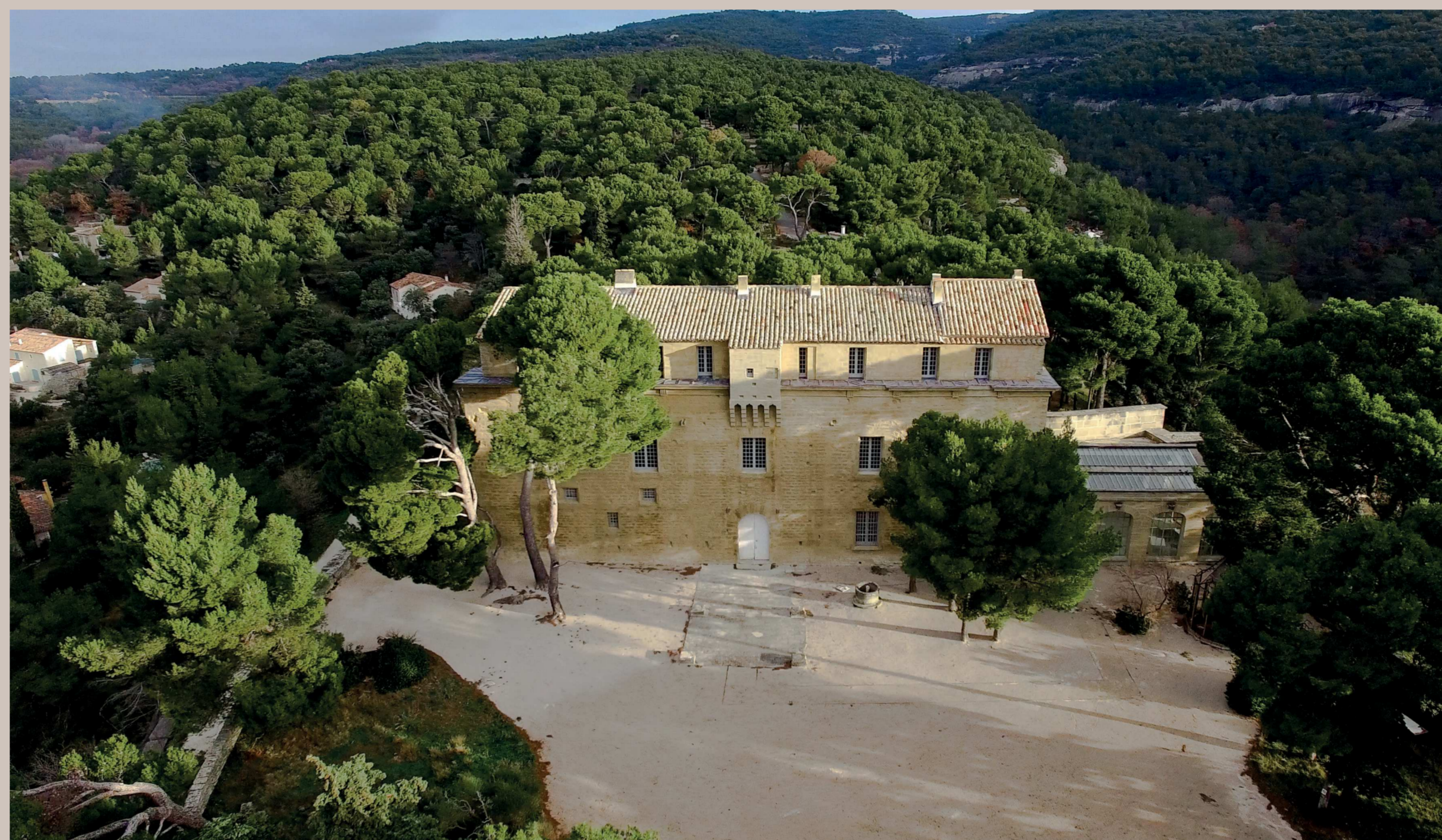
Façade sud : le logis médiéval, l'orangerie et l'esplanade
